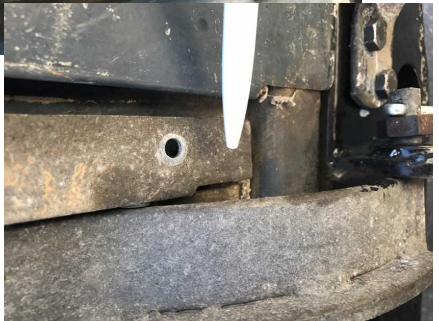
Heckklappenrahmen schweißen Rahmen 2
